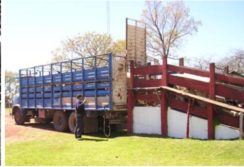
Figura 2. Camión estacionado en un embarcadero con tramo horizontal.
